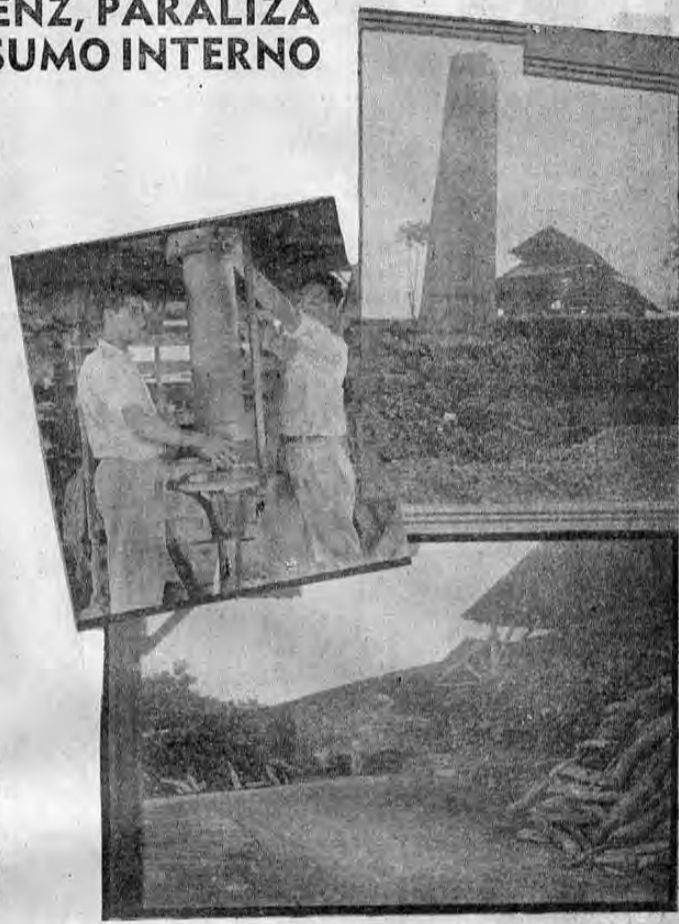
La máquina de hacer tubos en el momento de dejar caer uno que reciben dos operarios. A un lado: hermosísima vista de la chimenea del horno. Al fondo, parte de la fábrica.—Abajo: vista parcial de las bodegas de leña, cuyo costo total puede calcularse en diez mil colones
